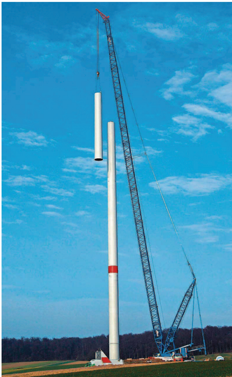
Dienstag begann die Errichtung des ersten Rades. FOTOS: STADTWERKE
