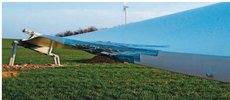
Der beschädigte Rotor, die schadhafte Stelle wurde abgeklebt.
