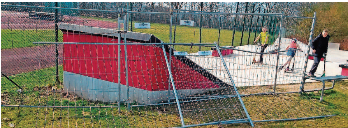
Wieder beschädigt: die Absperrung im Skatepark am Blättelbornstadion in Merzig. FOTOS: STADT
